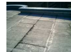
●屋上アスファルト防水
