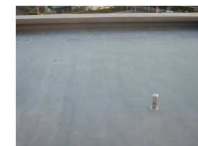
●屋上ウレタン防水
