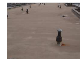
●屋上シート防水
