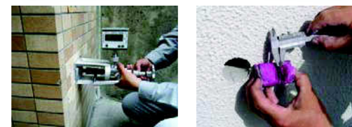
●タイル付着力引張り試験
