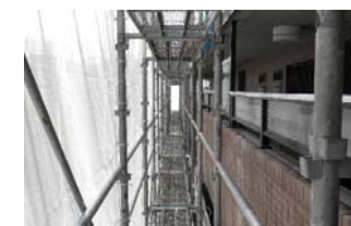
●足場にメッシュシートを取り付けた状態。内側から見るとこんな感じになります。
