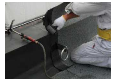
●立上り部の2回目シート貼り
