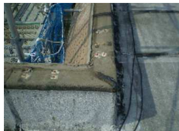
●既設防水を高圧洗浄
