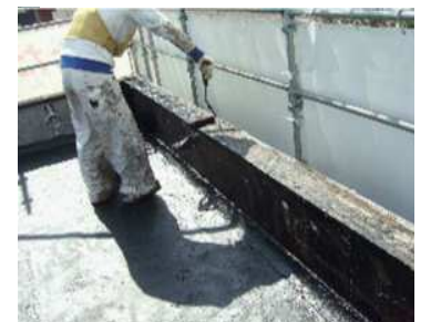
●立上り部にプライマー塗り
