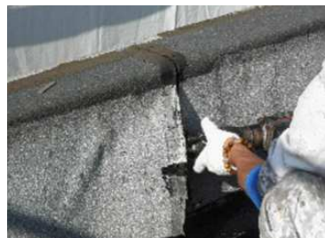
●立ち上り部の既設防水部の撤去
