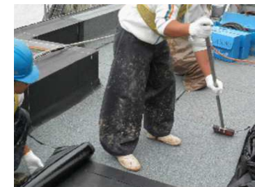
●2層目の砂付シート貼り
