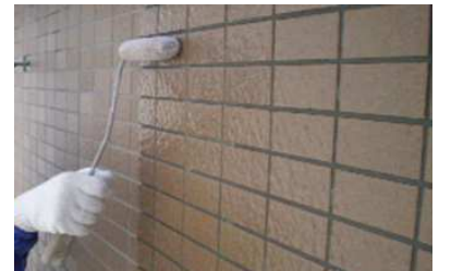
●外壁タイル 保護塗装
