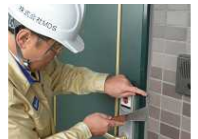
シールの調査
